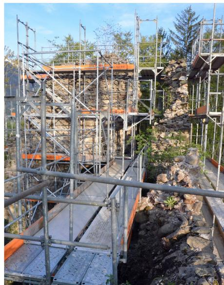
Reinigen und Ausbessern der Mauerkrone
